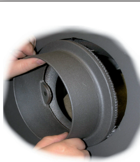
Fig. 6 Zet de rookkraag door de achterplaat tegen de verbran- dingskamer aan.
