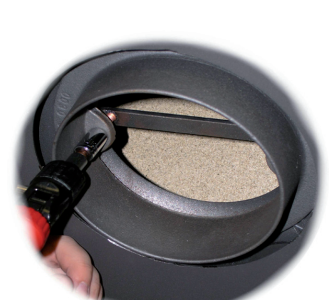
Fig. 8 Zorg ervoor dat de rookkraag in het midden zit en span de bouten aan.
