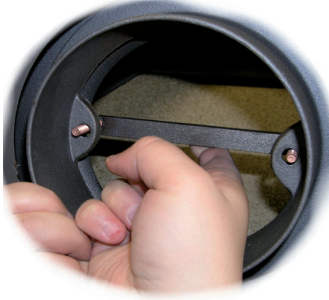
Fig. 7 Span de rookkraag achterop de kachel met de houder of met bouten vast.
