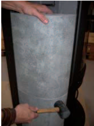
11. Utilisez un marteau en caoutchouc pour redresser doucement les côtés de manière à ce qu'ils soient bien droits.
